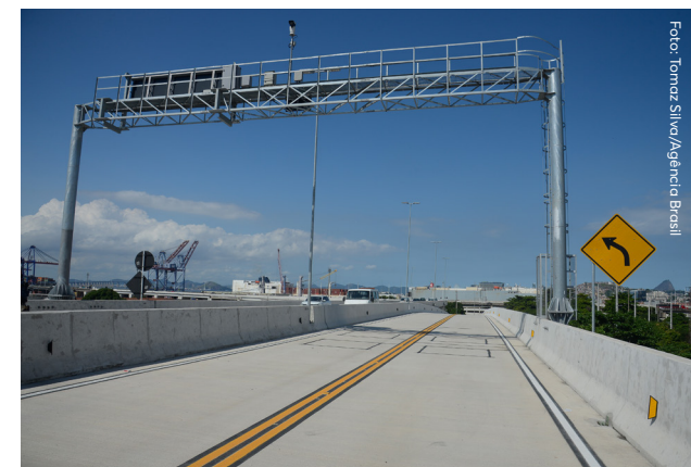
Pleito da Firjan Leste Fluminense, a Avenida Portuária foi inaugurada em abril, beneficiando o acesso de cargas transportadas por caminhão ao Porto do Rio
