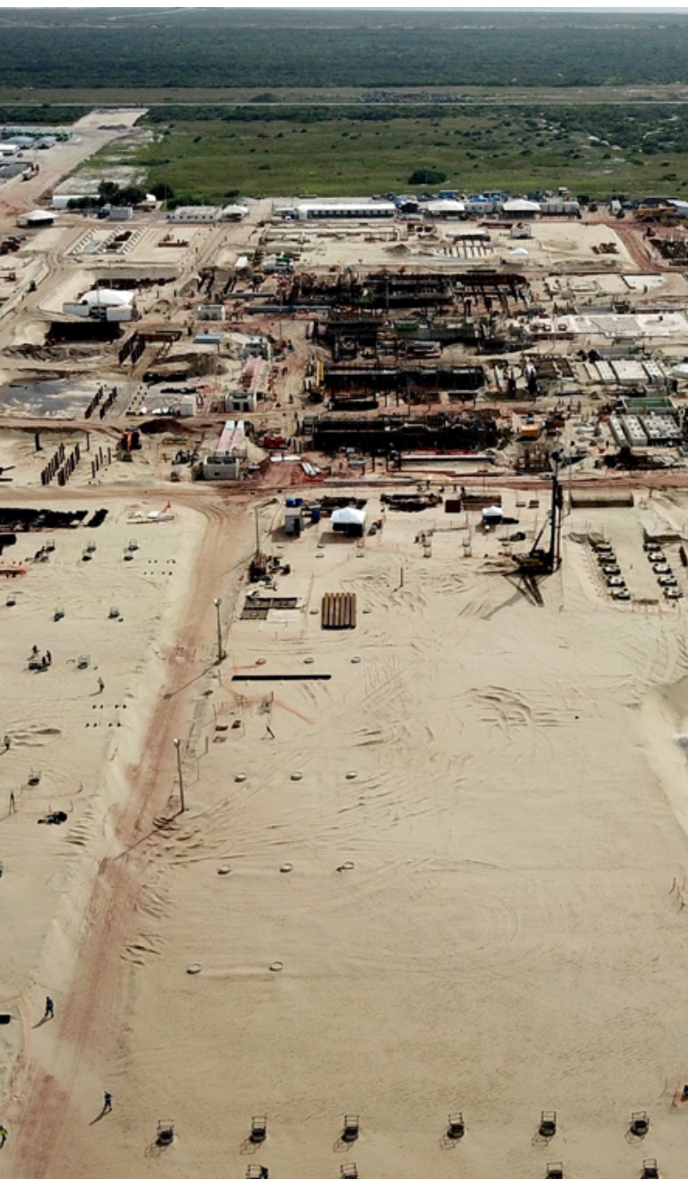
Foto da construção da UTE GNA I (outubro de 2018)
